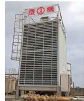
大園廠完成滋補飲品生產線增設 LCC-S 型密閉式節水冷卻塔 LCC-V-125S
